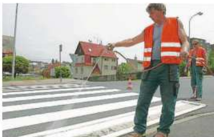
OBNOVA ZEBRY. Největší nebezpečí za nepříznivého počasí hrozí chodcům na čerstvě nastříkaných přechodech. Ilustrační foto: Deník
